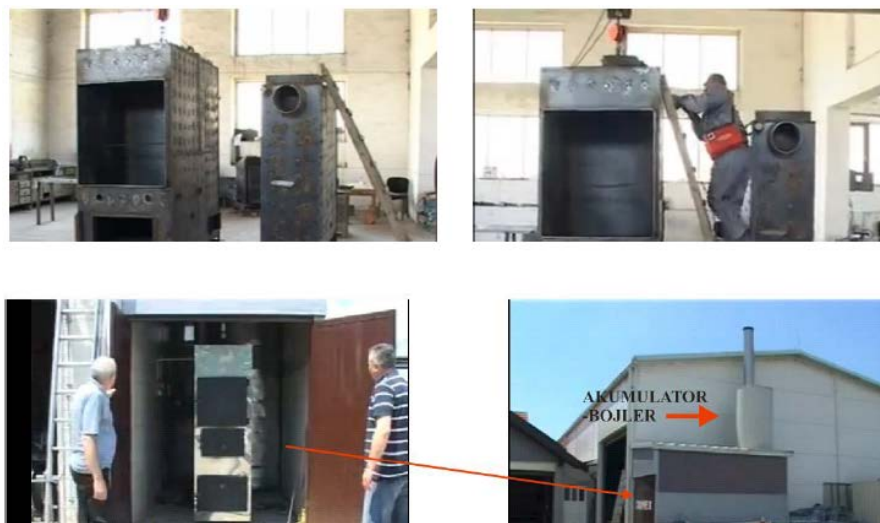
Слика 4. Инсерти из процеса монтаже
