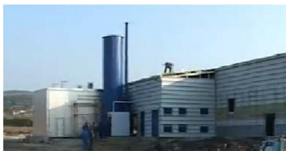
Пуштање у погон мини топлане са аку-бојлером у плавој боји
